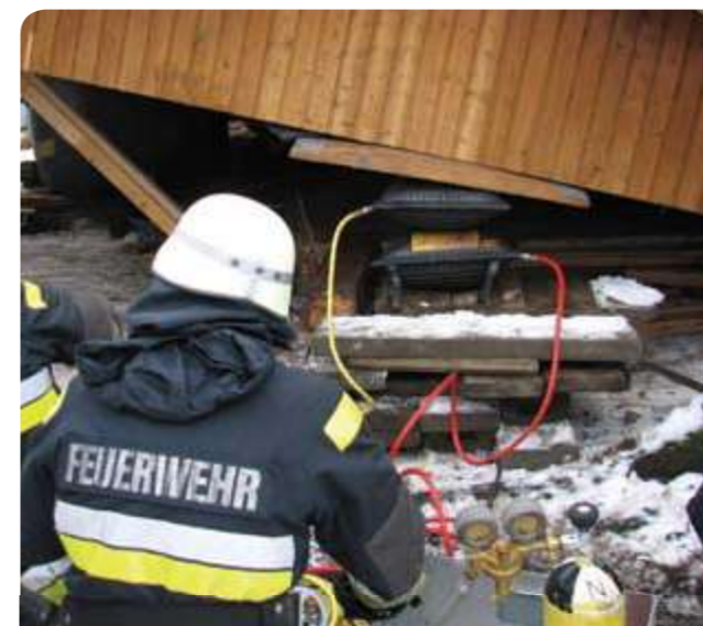
Работа двух пневмодомкратов вместе.
